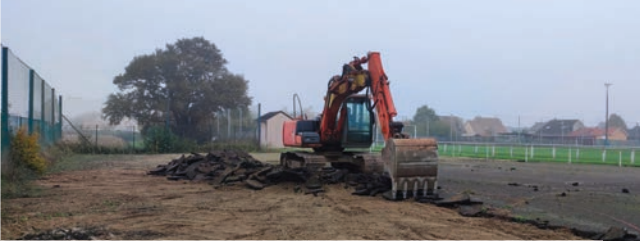
Décroûtage de l'enrobé des anciens terrains de tennis
