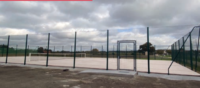
Réfection des terrains de pétanque Zone Espace Jeux Enfants - Végétalisation
